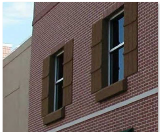
ドライビットのアウサレーションを使い、窓は押し出され、モールディングで窓敷居やシャッター、植木箱が模倣されました。
